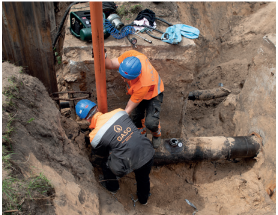
Dabasgāzes sadales infrastruktūras remontdarbi Rīgā, 2021. g.
