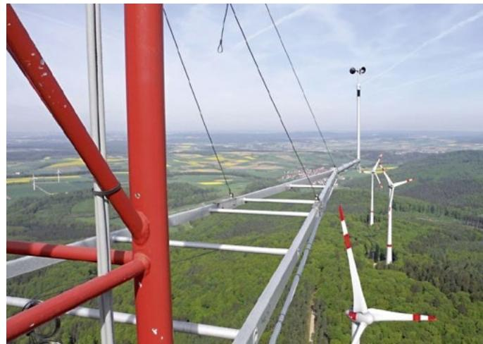
4. attēls. Eksperimentā izmantots viens no augstākajiem meteoroloģiskajiem mastiem Vācijā, kas uzstādīts Rödeser Berg pakalna virsotnē un kura augstums ir 200 m
